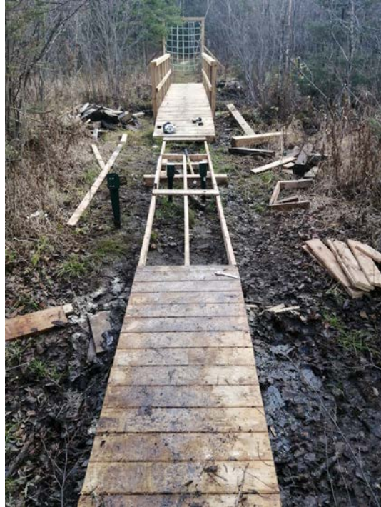
Photo 12 : Ajout de passerelle pour connecter le pont # 1.
