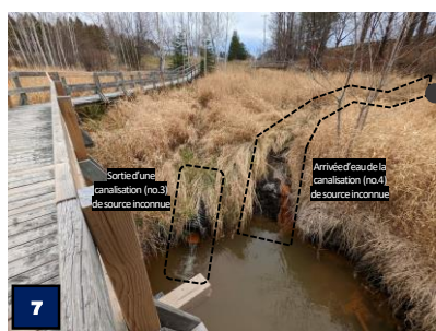
Érosion à la sortie des canalisations, apport modéré d'eau de la canalisation (no.3)
