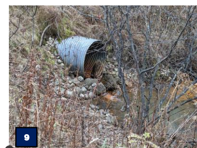
Sortie du ponceau
