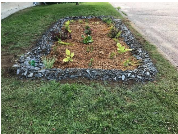
Jardin pluvial réalisé en 2022 à Albanel
